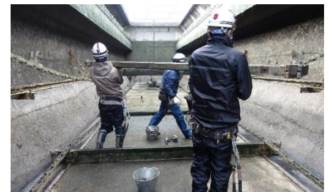
内浜処理場沈殿池汚泥掻寄機補修工事
